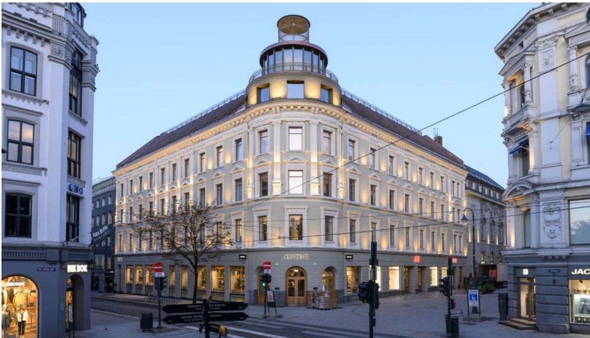
Karl Johans gate 14 blir AVA Eiendoms pilot for BREEAM In-Use.
